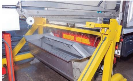
Benne en acier inoxydable pour la collecte des déchets du lavage intérieur, qui permet de maintenir la piste de lavage propre et évite l'accumulation d'éléments solides et de matière organique à l'étage de rejets.
